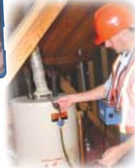
Ambient CO - Flue Test
